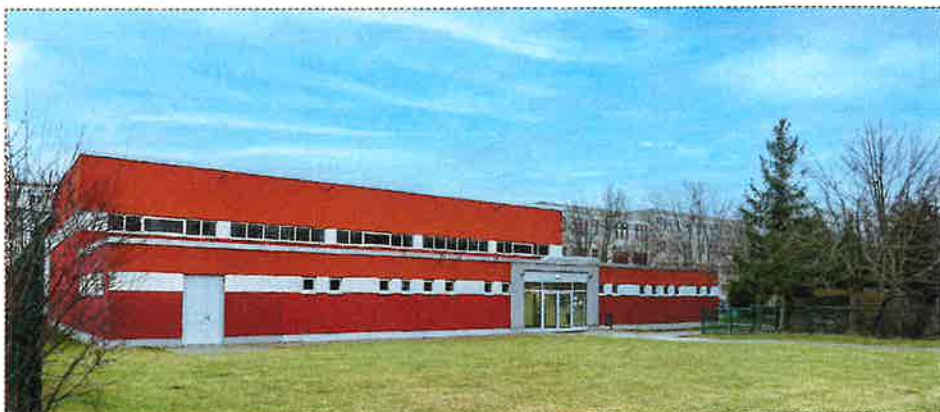
Die sanierte Sporthalle ist schon jetzt ein gelungenes Projekt © alle: Ariane Hofmann
